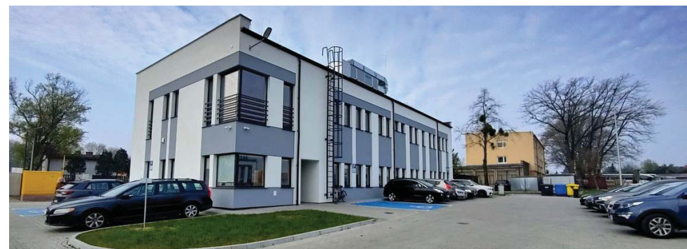
Nowe Biuro Obsługi Klienta na parterze biurowca, fot. ZUK
