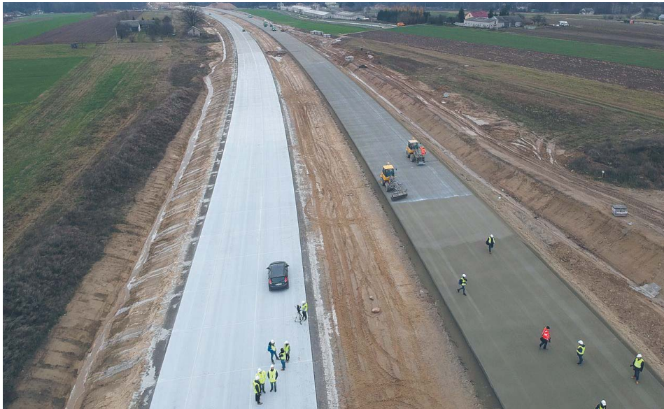
Na S17 niemal do końca grudnia trwało rozkładanie nawierzchni betonowej
