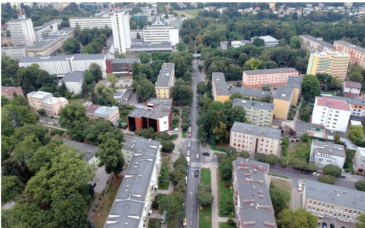
Obecnie jezdnia ul. Sowińskiego ma trzy pasy ruchu. Budowa czwartego wymagałaby poszerzenia jezdni, co wiązałoby się z wycinką drzew
