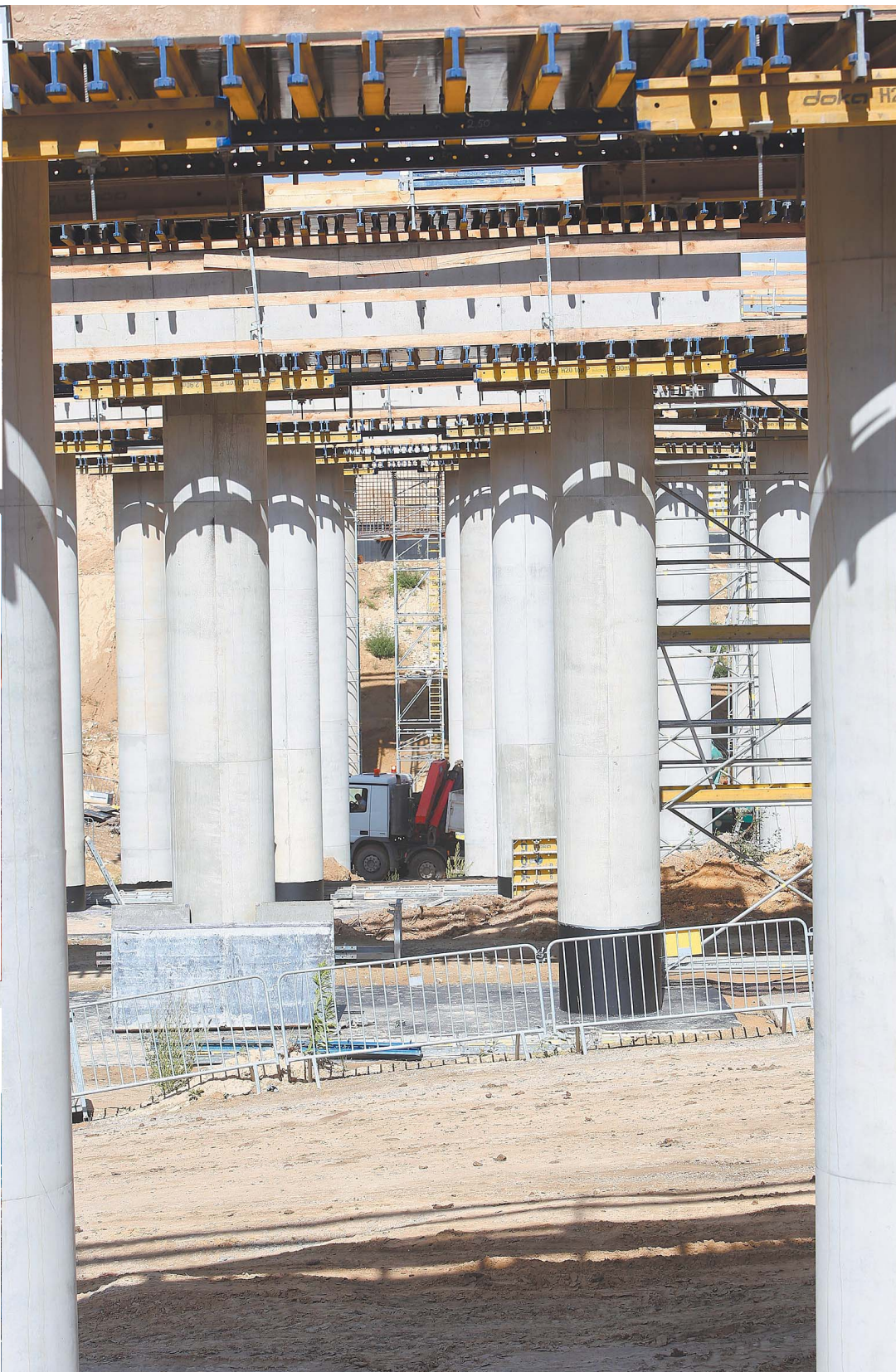
Przy budowie obiektów inżynierskich drogowcy muszą pracować z chirurgiczną dokładnością. Niektóre elementy estakad czy wiaduktów muszą być wykonane z tolerancją do milimetra. Najdłuższa estakada ma ponad 200 metrów długości i 17 wysokości
