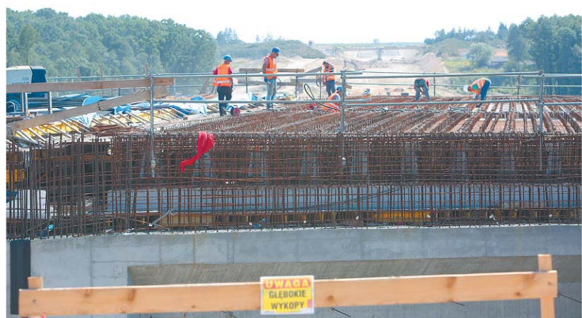
Na budowie S19 pracuje blisko 1500 osób
