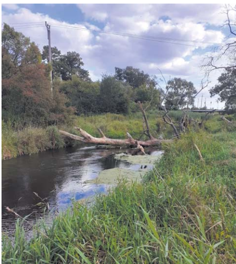
Powodem zalewania gruntów rolnych mają być zarośnięte i zaniedbane koryta rzek
