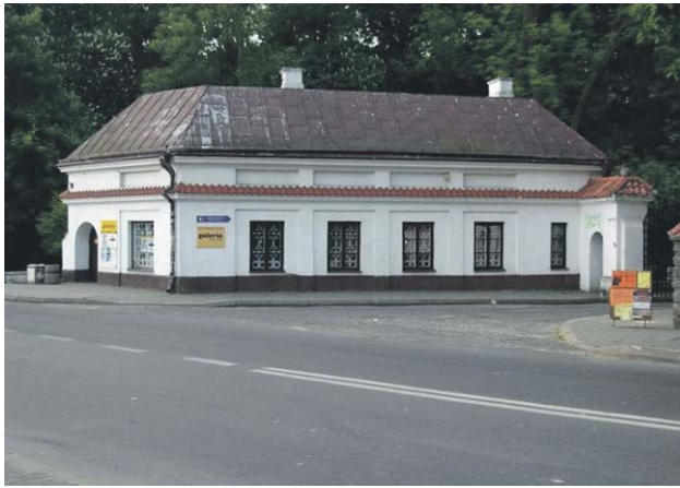
Budynek Galerii Podlaskiej
