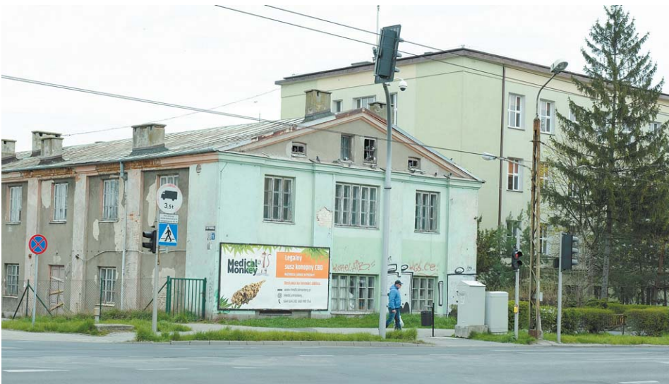
Konieczna będzie rozbiórka narożnego budynku
