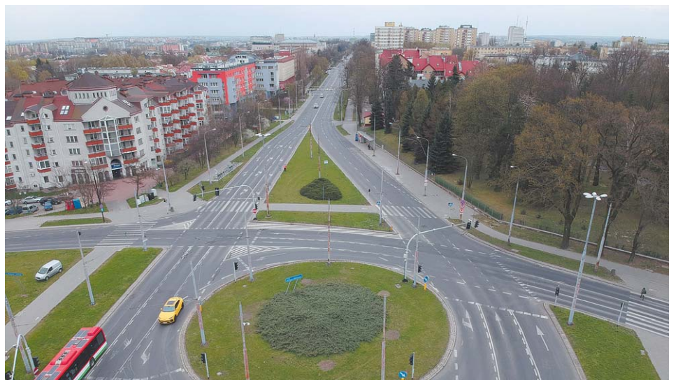
Najprawdopodobniej od strony ronda zaczną się rozbiórki krawężników FOT. MACIEJ KACZANOWSKI
