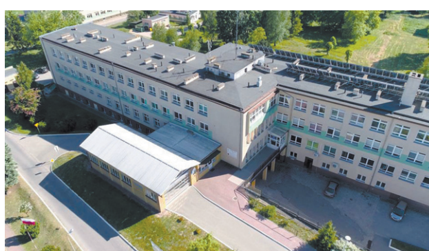
FOT. SZPITAL W PARCZEWIE
