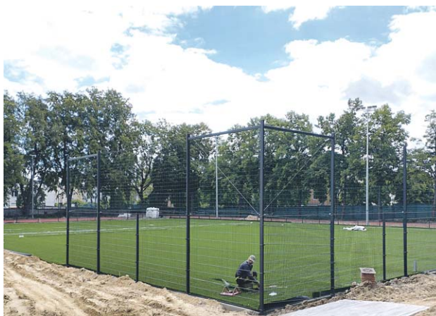
Aktualnie na placu budowy trwają m.in. prace przy układaniu sztucznej trawy na boisku piłkarskim
