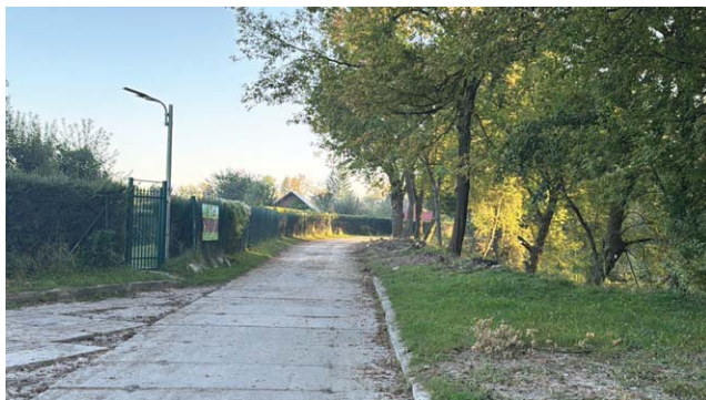
Po zakończeniu prac obecna droga z betonowych płyt prowadząca do zalewu będzie wyrównana, a jej pobocza uporządkowane
