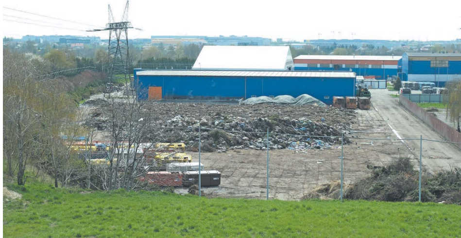
Zakład miałby powstać na peryferiach Lublina, w miejscu zajmowanym obecnie przez kompostownię odpadów zielonych
