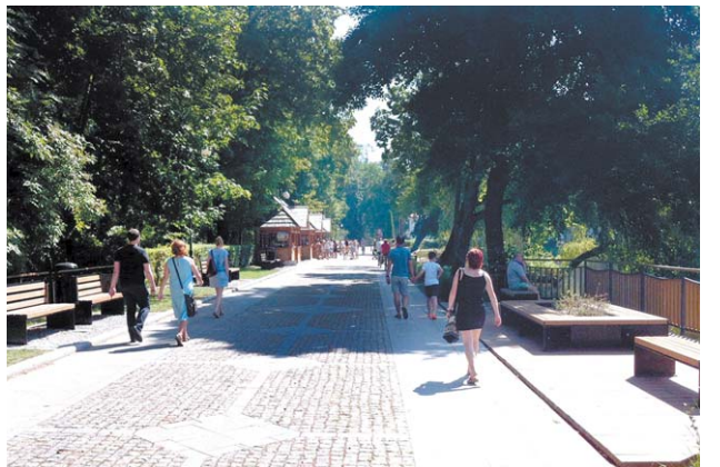
Zakres prac to rozbiórka istniejącego drewnianego pomostu, wykonanie nowego oraz remont ławek – wymiana drewnianych siedzisk i oparc
