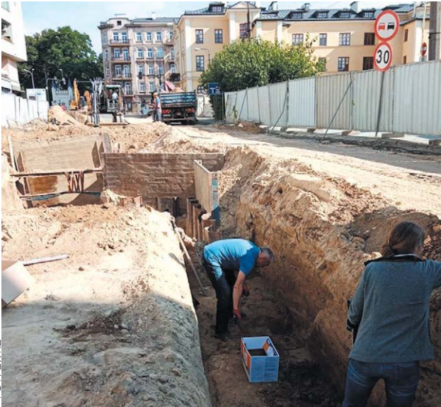
Szczątki znaleziono w środę podczas prac drogowych na ul. Lipowej
