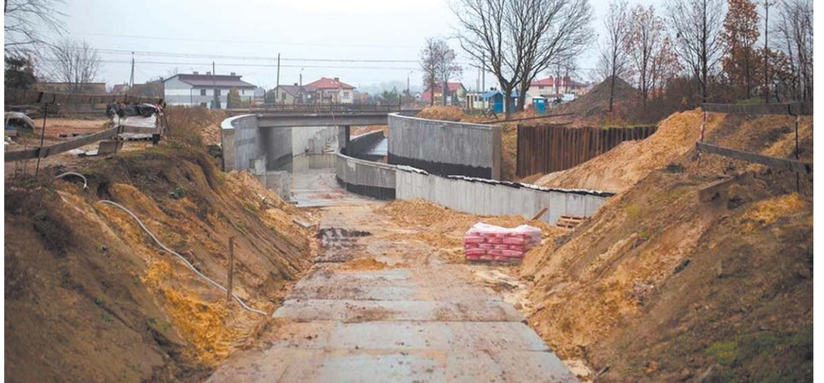
Tak wyglądały w minionym roku prace przy tunelu
