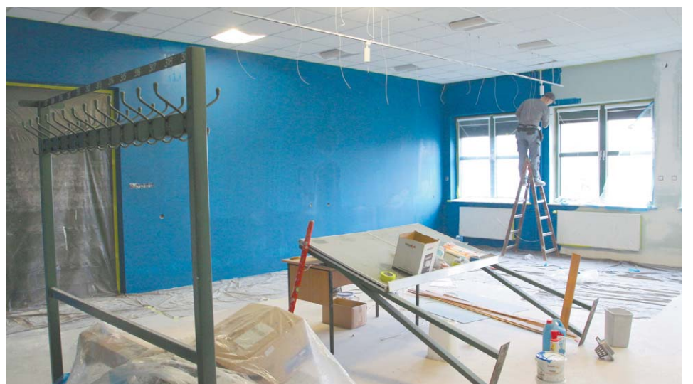
W gmachu przy ul. 4 Pułku Piechoty kończą się prace adaptacyjne. Część pomieszczeń już przemalowano, a pod koniec stycznia powinien zacząć się montaż docelowej ekspozycji
