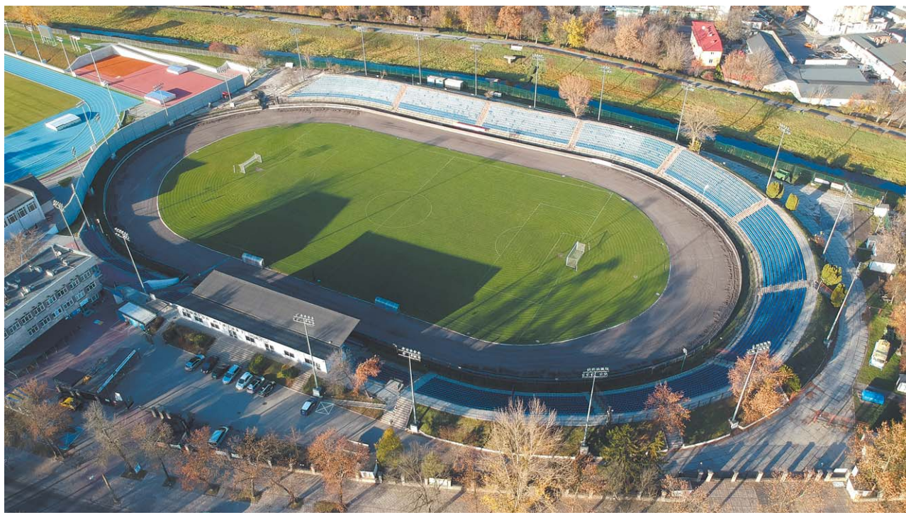
Pierwszym z sześciu zadań jest odnowa trybun. MOSiR oczekuje zdemontowania siedzisk, wylania nowego betonu i ponownego zamocowania krzesełek
