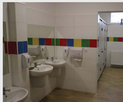
Remont sanitariatów oraz wykonanie łazienek dostosowanych do osób niepełnosprawnych w 5 obiektach
