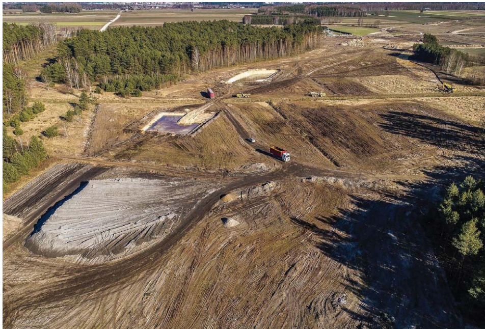
Budowa A2 na odcinku od Gręzowa do Siedlec
