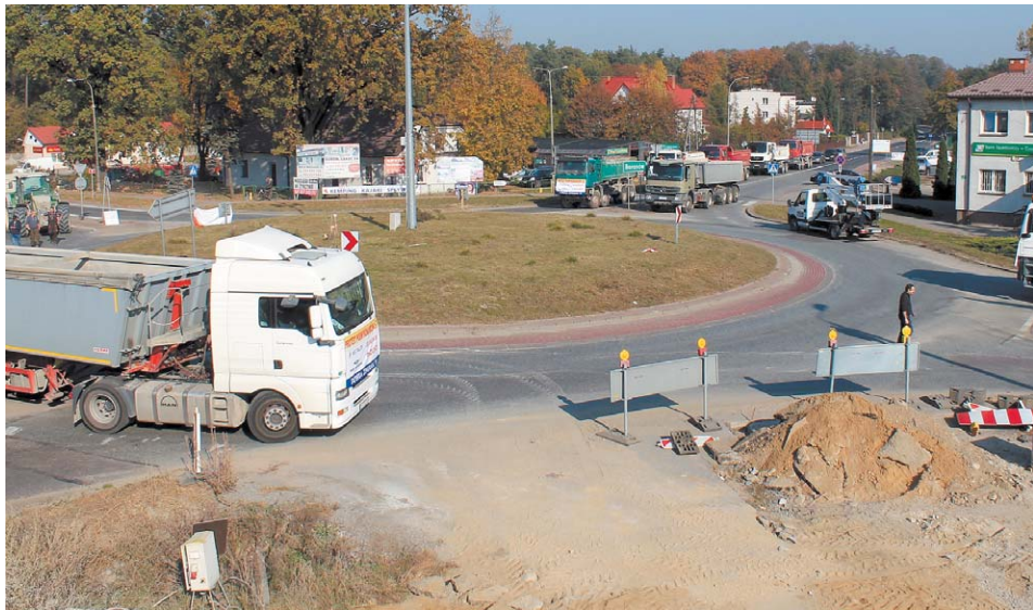
Dzięki budowie S17 wzrosła atrakcyjność działek położonych pomiędzy starym (na zdjęciu), a nowym rondem w gminie Żyrzyn. Większość terenów inwestycyjnych w pobliżu węzła została wykupiona
