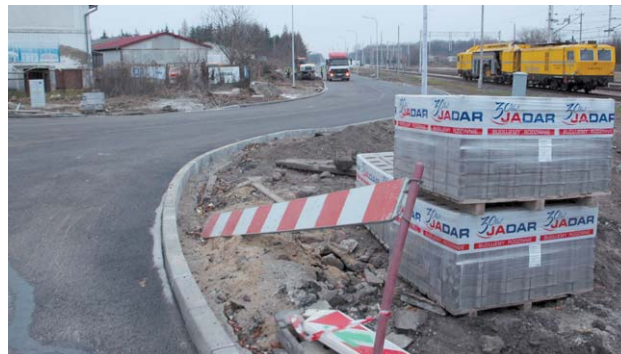
Ul. Składowa wkrótce nie będzie ślepa. Dzięki nowemu, 600-metrowemu odcinkowi prowadzącemu wzdłuż torów kolejowych, dojedziemy nią do Kolejowej
