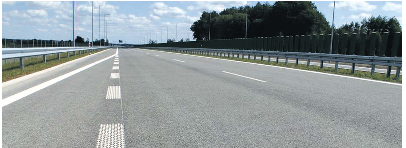
S12 - na ekspresowe połączenie Lublina z Radomiem kierowcy czekają już zdecydowanie zbyt długo
