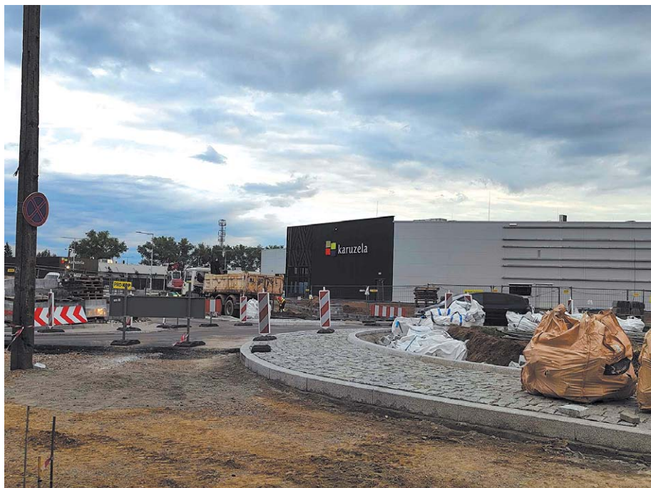
Trwają ostatnie prace wykończeniowe
