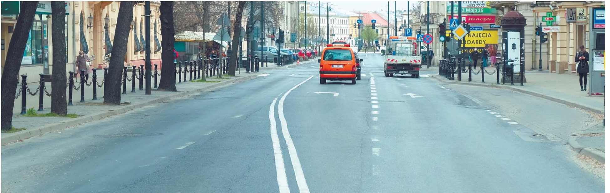
Remont ma objąć ponad 440 m jezdni. Prace będą polegać na zderciu sfatygowanej nawierzchni na głębokość ok. 10 cm
