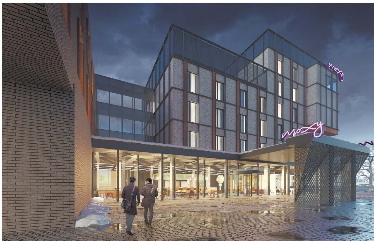
Nowy hotel przy ul. 1 Maja w Lublinie zbuduje lubelska firma CRH Holding. Obiekt powstanie w miejscu wyburzonych kamienic. Hotel ma działać pod należąca do sieci Marriot marką Moxy
