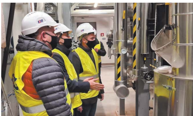
Próbné uruchomienie ciepłowni
