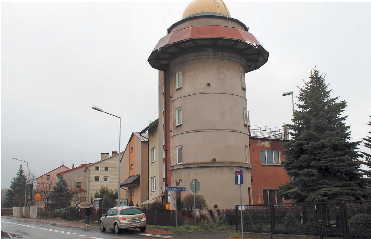
Puławskie obserwatorium w tym roku przejdzie kapitalny remont
