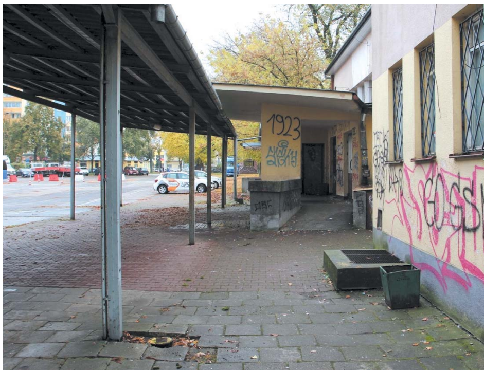
Dworcowy plac ze starą poczekalnią i pustostanem dawnego kasyna wojskowego to obecnie jedna z najbardziej zaniebanych części Puław
