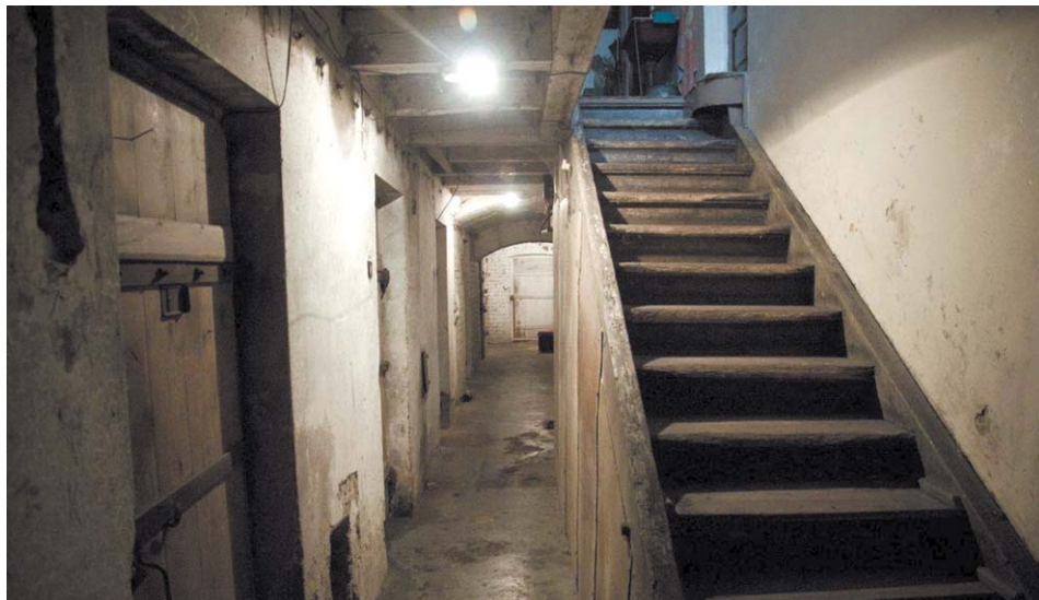
W budynku zachowały się oryginalne cele i drzwi z judaszami
