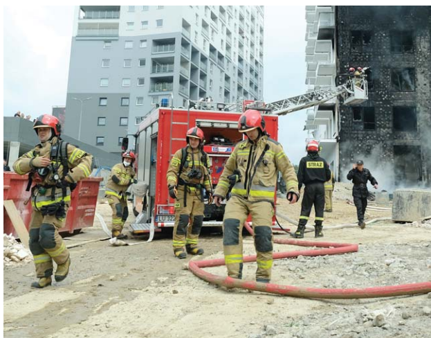
Do pożaru nowo budowanego wieżowca przy ul. Północnej w Lublinie doszło przed tygodniem
