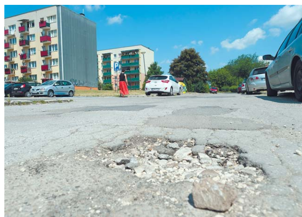
Ulica Witosa to jedna z najdłuższych oczekujących na realizację inwestycji Świdnika
