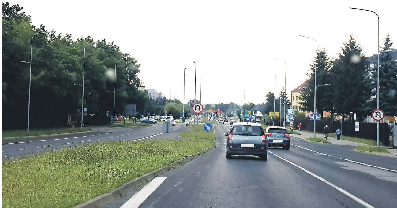
Na ulicy Wyszyńskiego (w planie przebudowy dróg uwzględniona w roku 2026) pas zieleni, którym teoretycznie miałyby jeździć tramwaje rzeczywiście jest. Są jednak również zbudowane niedawno ronda
