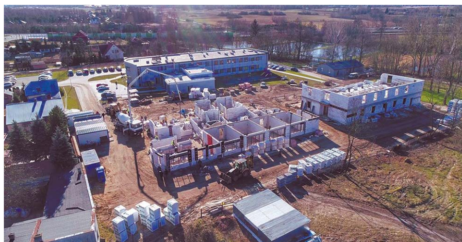
Budowa kolejnych budynków Centrum Pomocy Osobom z Autyzmem
