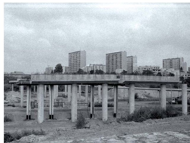
Budowa wiaduktu nad ulicą Filaretów
