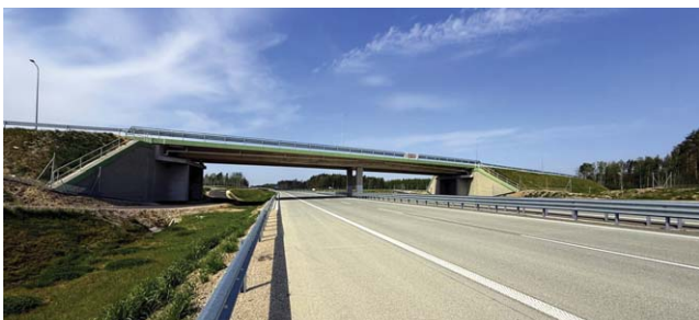
Otwierany w piątek fragment A2 dzielił się na dwa odcinki, ten z Siedlec do Malinowca budowany przez Strabag oraz z Malinowca do węzła Łukowisko, za który odpowiada Intercor
