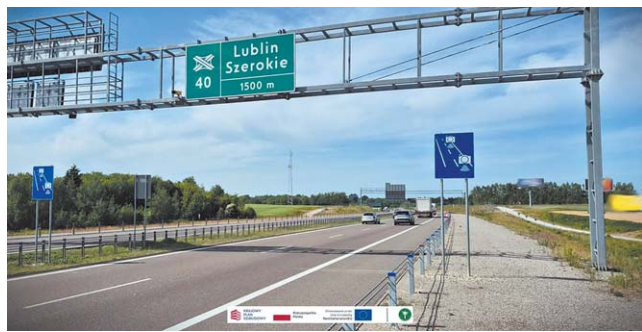
Bramownica z kamerami odcinkowego pomiaru prędkości nad drogą S19 w okolicach Lublina FOT. CANARD
