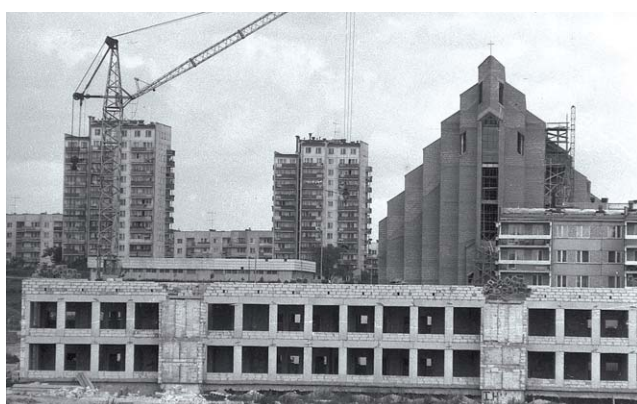
Budowa Kościoła Świętej Rodziny przy ulicy Jana Pawła II
