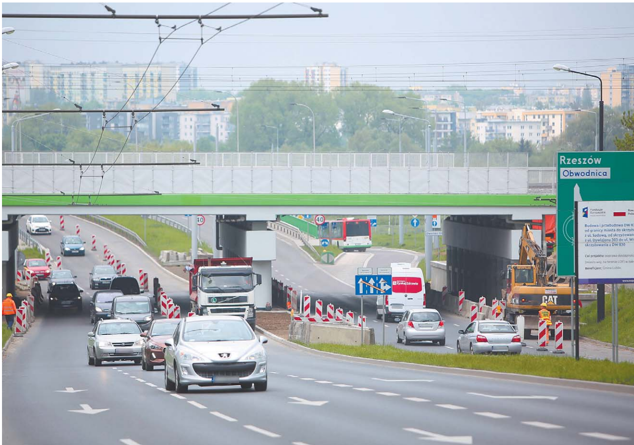
Prace przy wiadukcie dobiegają końca
