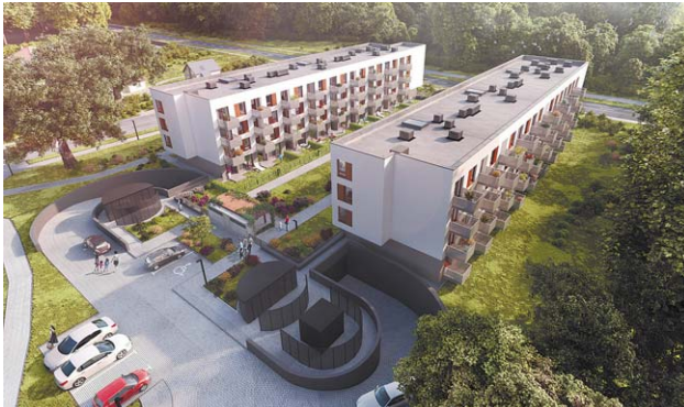
Miedzy ul. Kopernika, Spacerową i Sosnową powstaje trzypiętrowy blok „Apartamentów Kopernika”
