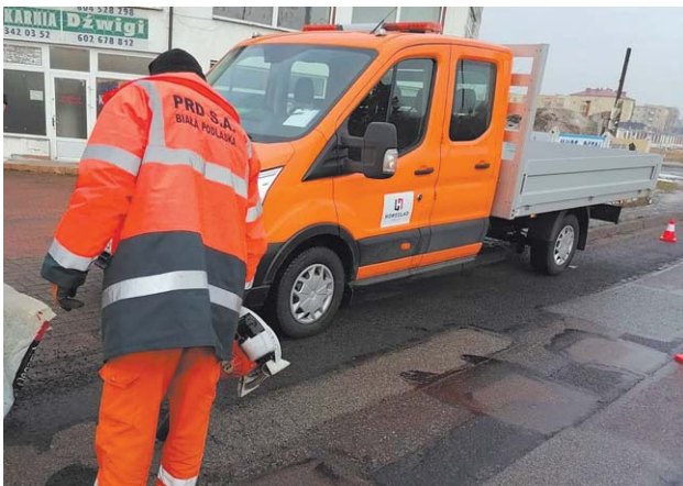
Remonty ubytków w jezdniach trwają od początku lutego
