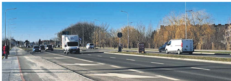
DK 74 nazywana też małą obwodnicą Zamościa została gruntownie przebudowana na odcinku prawie 5 km. Ma nową, gładką nawierzchnię, skrzyżowania są teraz rondami, zbudowano nowe chodniki i ścieżki rowerowe. Cała inwestycja kosztowała ok. 96 mln zł, z czego 82 mln zł stanowiła unijna dotacja
