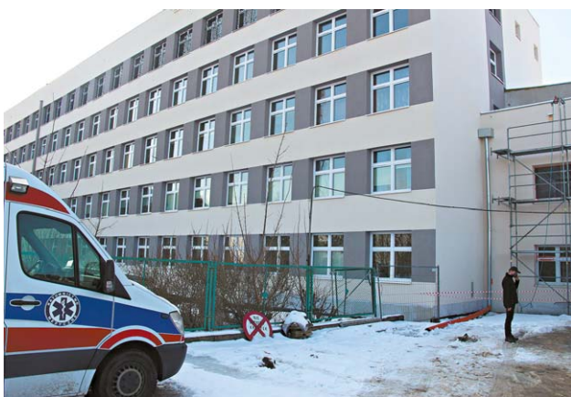
Teraz lecznica przygotowuje się do kolejnej inwestycji, która została zaplanowana do realizacji w systemie „Zaprojektuj - buduj”
