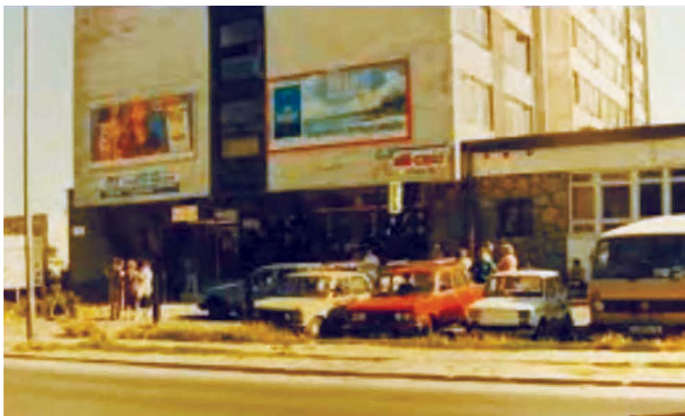
Hotel Oaza, później hotel Polonia (wczoraj i dziś) – obecnie budynek mieszkalny
