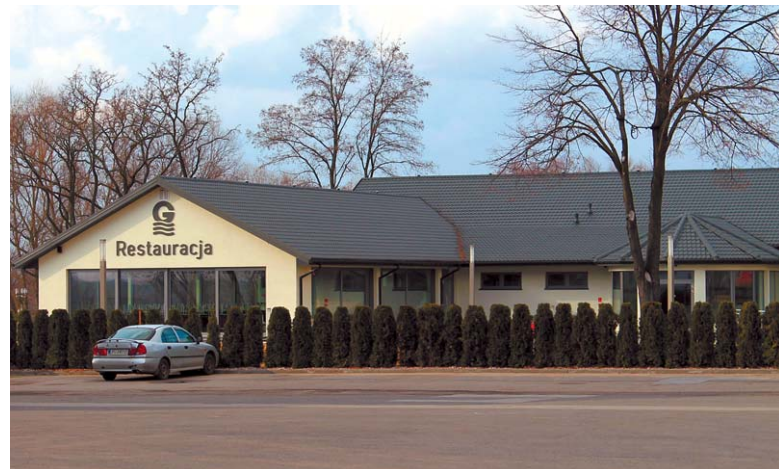
Gościniec nad Wisłą jest już w pełni legalnym obiektem
