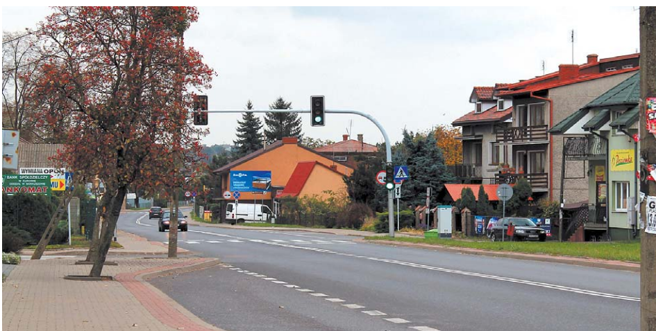
Gmina Markuszów, która otrzymała trzy dotacje w ramach „Polskiego Ładu”, łącznie ponad 8,3 mln zł: na rozbudowę wodociągu, remonty dróg i budowę nowego targowiska.
