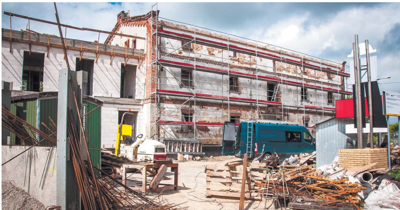
Po przebudowie w spichlerzu znajdzie swoje miejsce 60 podopiecznych Środowiskowego Domu Samopomocy
