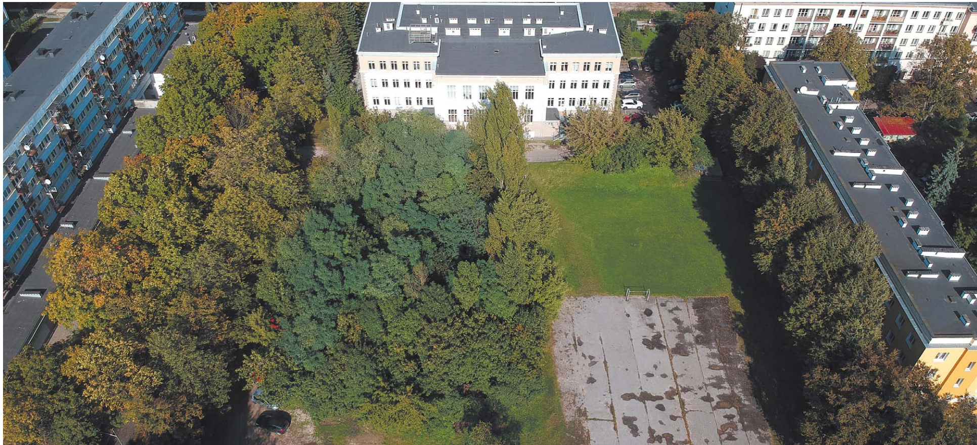
Piłkarskie boisko ze sztuczną murawą powstanie w miejscu, w którym jest teraz asfaltowe boisko
