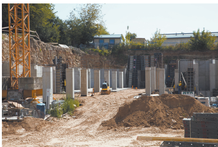
Diamentowe Wzgórza blok G ul. Wolińskiego
