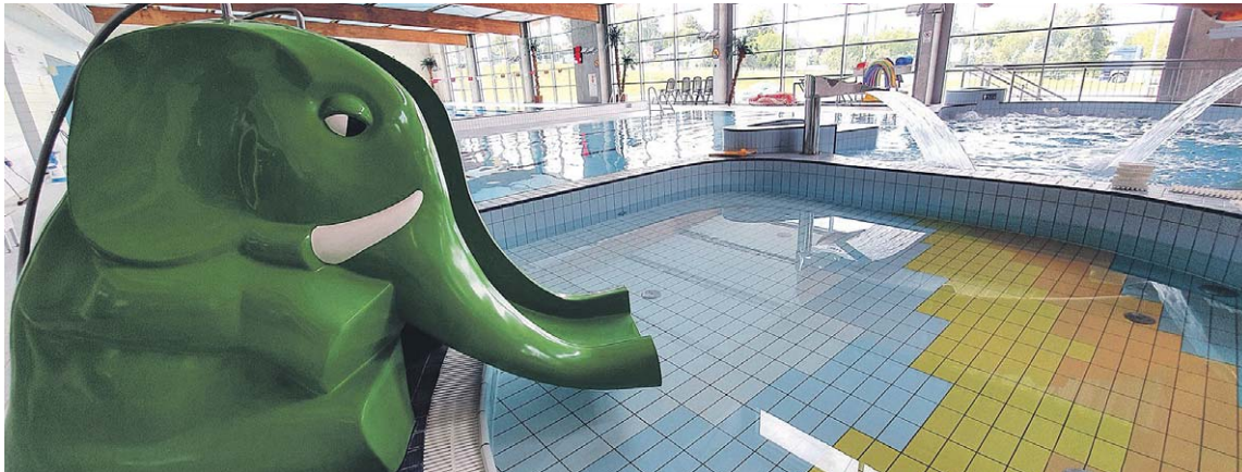
Jedną z poważnych inwestycji planowanych w 2023 roku przez rycki powiat jest przebudowa pływalni krytej przy ul. Janiszewskiej w Rykach. Obiekt zyska nową część: SPA
