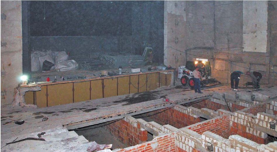
Sala MOK w trakcie remontu
