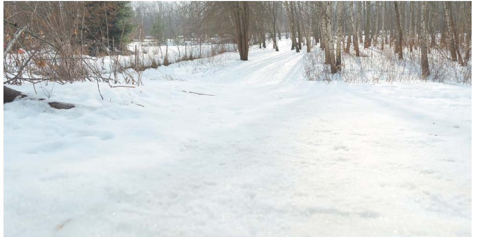
Droga do przystanku kolejowego, który ułatwił podróże znacznej części miasta, wciąż przypomina tor przeszkód
