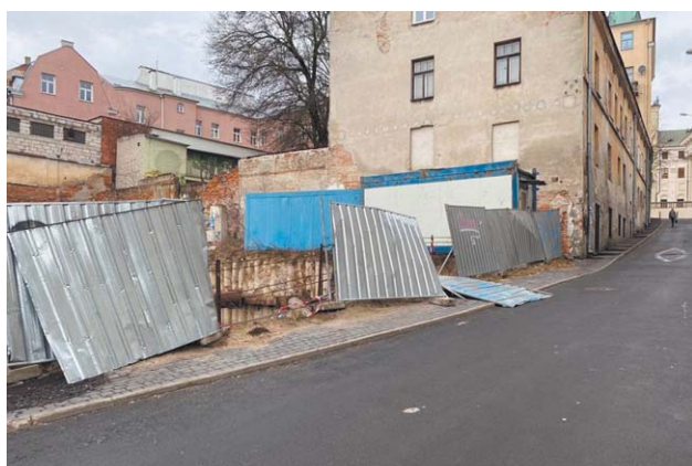
Tak zabezpieczony był plac budowy wczoraj
