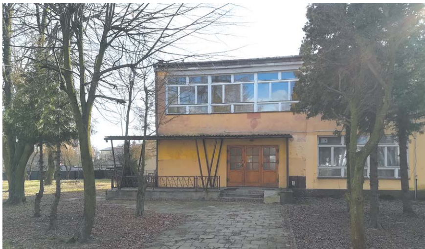
Budynek przy ul. Reja zostanie gruntownie wyremontowany. Znajdzie się w nim miejsce na żłobek
