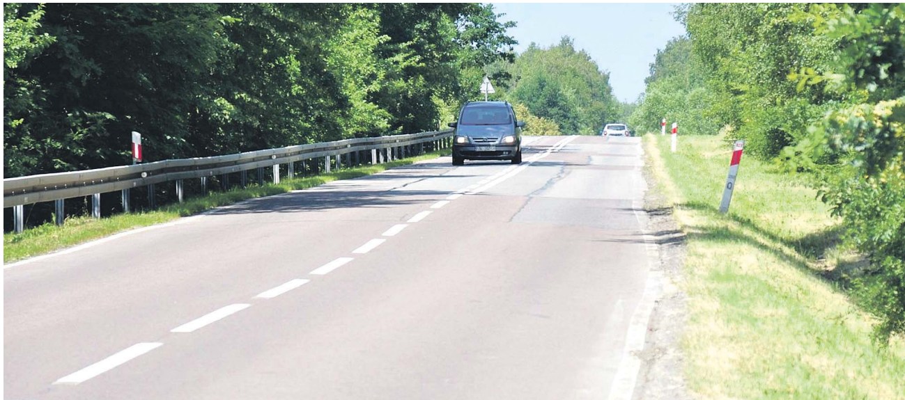
Droga zostanie rozbudowana na odcinku ok. 8,7 km, a na fragmencie ok. 1,6 km wyremontowana
