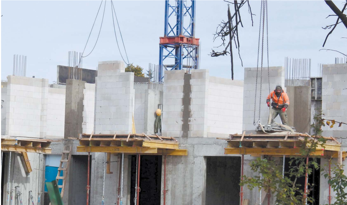
Blok Wikany przy ul. Bohaterów Monte Cassino jeszcze powstaje. Ma być gotowy do maja 2024 roku
