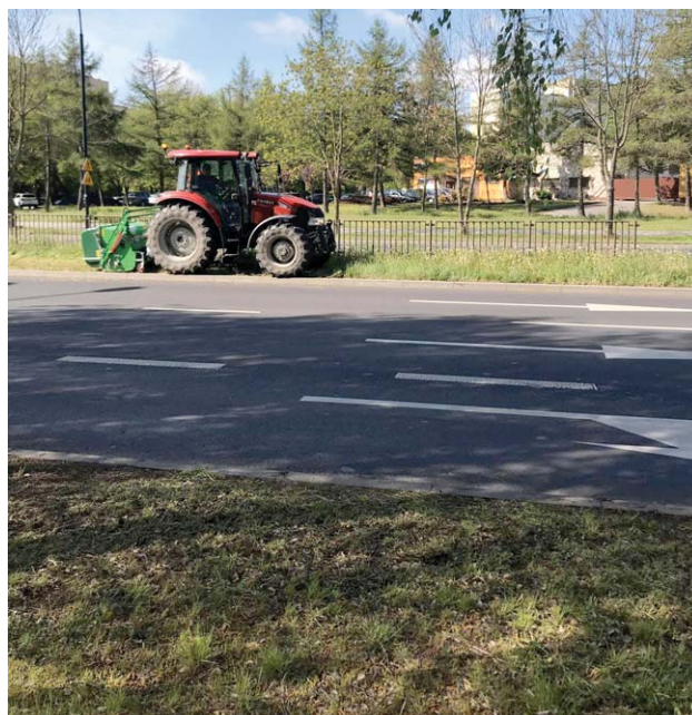
Wczorajsze prace prowadzone między jezdniami al. Kompozytorów Polskich
